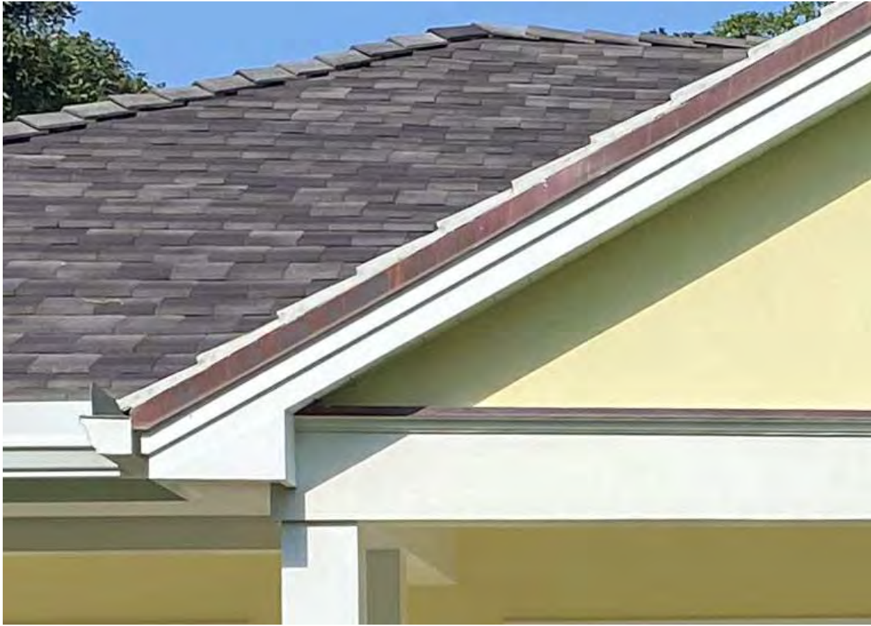
ROOF EDGE WITH COOPER DRIP EDGE
